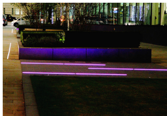
41,5 mètres de linéaires 5620-Brunei avec 120 LED/m en blanc chaud, optique 20° asymétrique.
