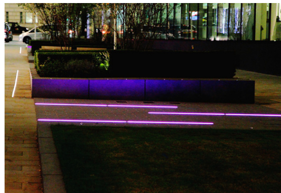
10 barreaux lumineux homogènes 5623-Brunei longs de 1,5 mètres fonctionnent avec changement de couleurs.
