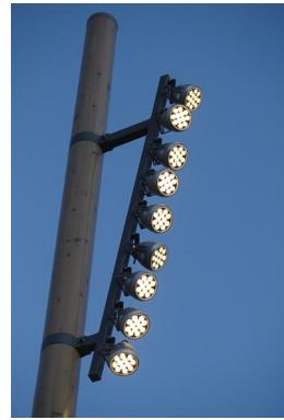
Les 45 projecteurs à LED orientables LEC Luminy 4 – 4040, équipés chacun de jeux d'optiques adaptés, permettent d'obtenir un éclairage de ces formes parfaitement homogène au sol. LEC a conçu 3 groupes indépendants de projecteurs sur chacun des mâts :
