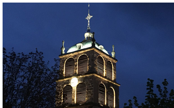
2 Lignon ref 5655 4000K de chaque côté de la toiture (8 au total) subliment le dôme du clocher et mettent en valeur sa couleur verte
