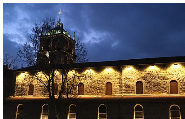
Plusieurs Lima ref 5683 3000K sont installés régulièrement tout au long de la façade côté jardin pour éclairer l'édifice et sublimer les murs en pierres.
