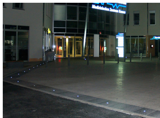
2 x 5716-CW7-06 Allevard, 7 superwatts 3W blanc froid, orientable ouverture 6°
