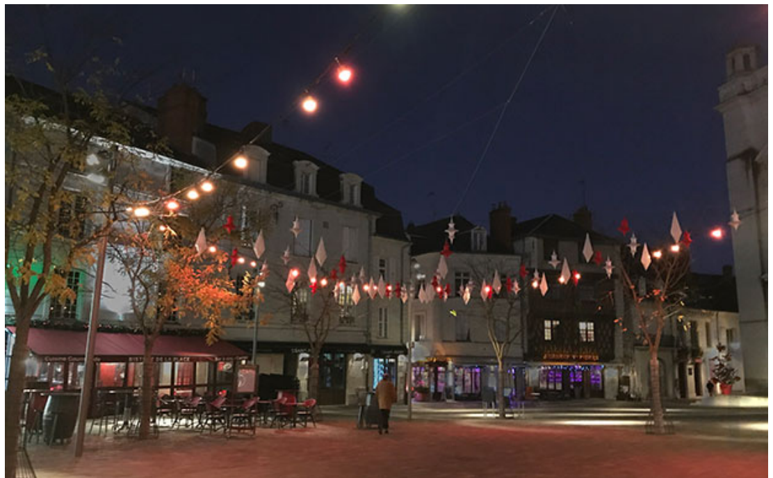
Luminaires spéciaux type guinguette - 4 lignes de 11 luminaires suspendus, en aluminium anodisé et boule sablée contenant chacune 4 led de puissance RGBW IP68
