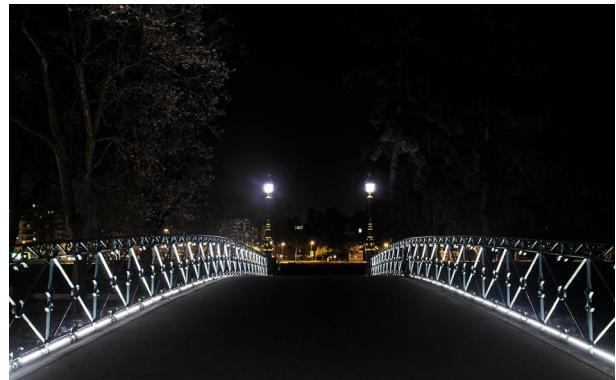
Le garde-corps est éclairé avec deux lignes de 22 m de linéaire 5620-Brunei, , avec 160 diodes par mètre, en blanc 4000°K le long du pont de chaque côté soit 44 m.
