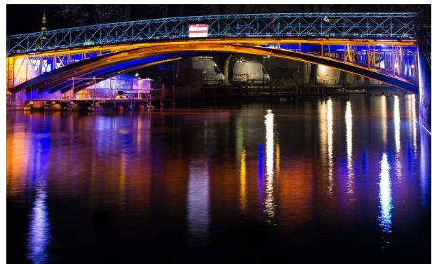
La sous face du pont est mise en lumière avec 12 projecteurs linaires 5633-Arches en ambre et sa partie centrale est éclairée par 6 projecteurs 5633-Arches en bleu. Différentes optiques sont utilisées.
