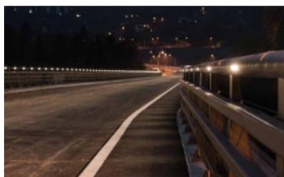
Le pont de Saint-Gervais bénéficie d'un éclairage fonctionnel avec une solution discrète, de jour comme de nuit, permettant un éclairage uniforme de l'ensemble du tablier de 12 mètres de large.
