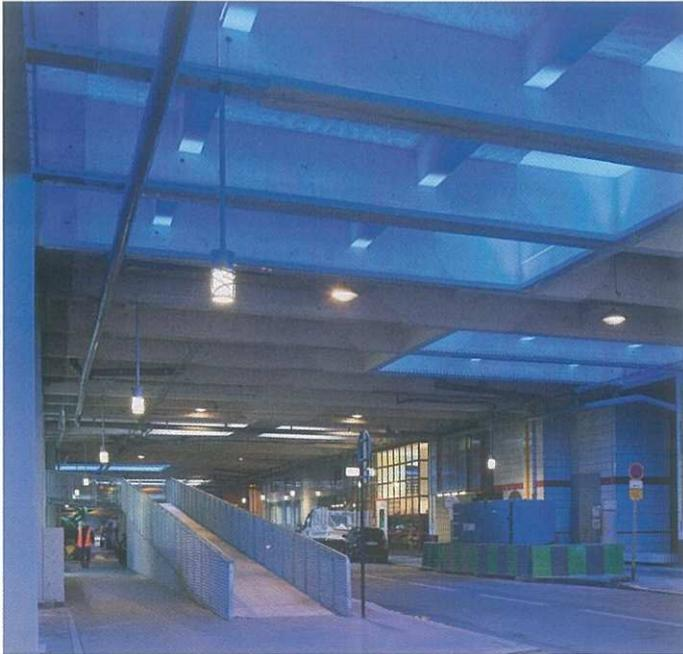
Abb.: In der Unterführung wurden per DMX angesteuerte LED-Lichtlinien installiert. Abhängig von den Tageszeiten wechselt jetzt das Spektrum der Beleuchtung.
